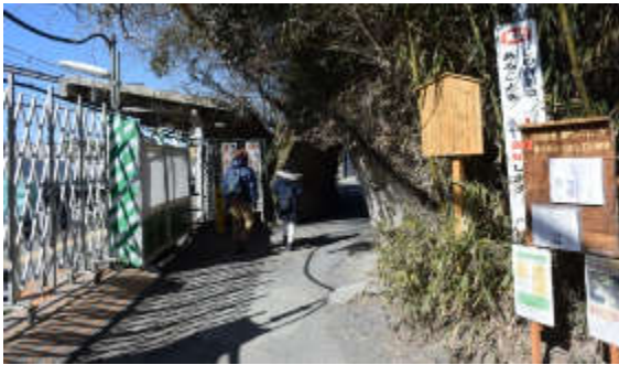
<駅に隣接する洞門。右に、貴重な文化財、この洞門が壊されようとしている、などの立札がある>
